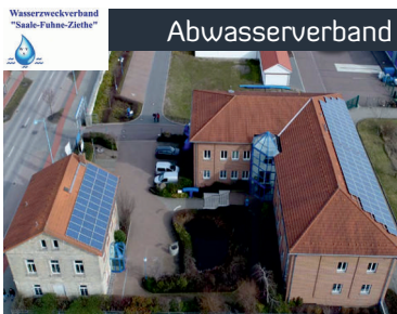
Abwasserverband 1 Gebäude 39 Räume 41 Heizkörper
