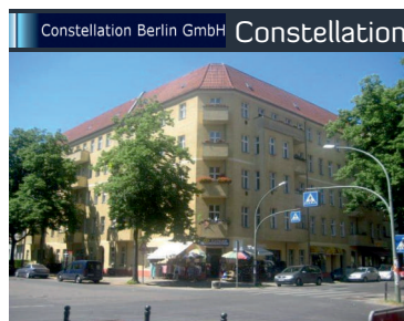
Constellation Berlin GmbH Constellation 1 Gebäude 110 Räume 124 Heizkörper
