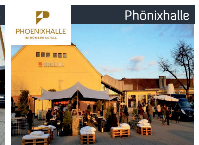
Phönixhalle 1 Gebäude 1 Räume 85 Heizkörper
