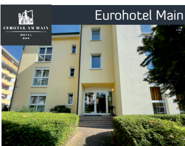
Eurohotel Main 1 Gebäude 162 Räume 178 Heizkörper
