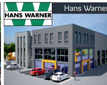
HANS WARNER Hans Warner 3 Gebäude 55 Räume 195 Heizkörper
